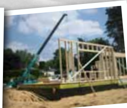
Charpentes en bois
