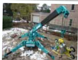
Pose de vitrages
