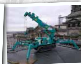
Levage sur toit
