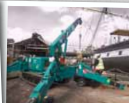
Travaux de levage variés
