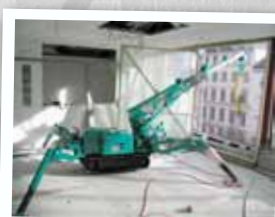
Pose de vitrages
