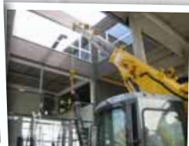
Pose de vitrages
