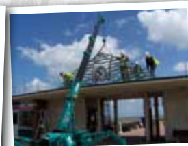
Travaux de levage variés
