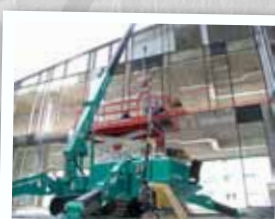
Pose de vitrages
