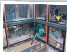
Pose de vitrages
