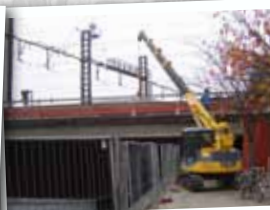
Travaux de levage variés
