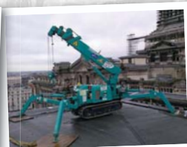
Sollevamento sul tetto
