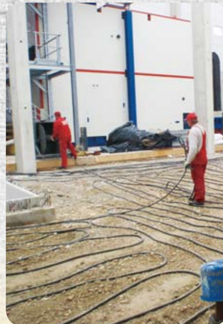
Fase 1: A seconda della temperatura, il terreno deve essere sgelato e riscaldato prima del trattamento. L'E 700M Wacker Neuson è pertanto il perfetto acceleratore dei lavori.
