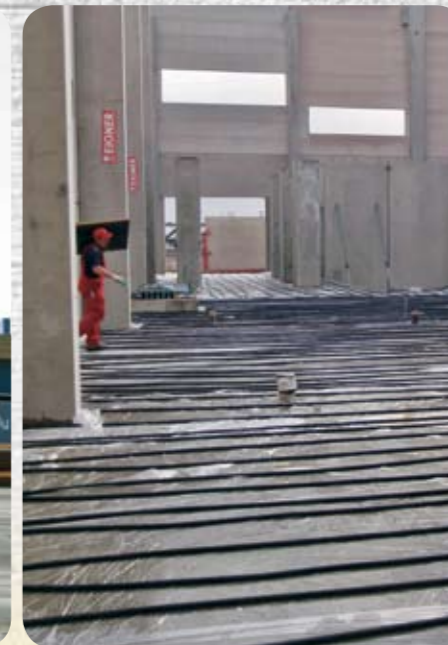
Fase 9: La maturazione impedisce un raffreddamento e un'essiccazione troppo rapidi del calcestruzzo durante l'indurimento. Il riscaldatore per superfici E 700M Wacker Neuson è l'ideale, perché garantisce un processo di indurimento stabile grazie alla forza di riscaldamento su tutta la superficie.
