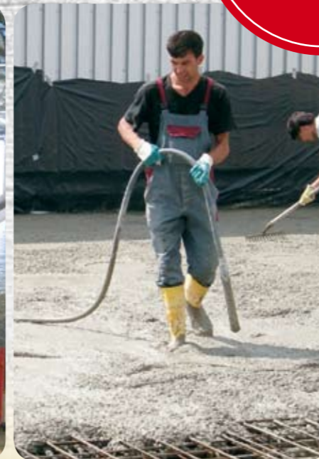
Fase 6: Il calcestruzzo deve quindi essere compattato, in modo da risultare di prima qualità. A tal fine è disponibile una vasta gamma di vibratori interni Wacker Neuson.
