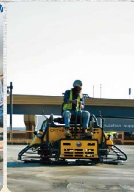
Fase 8: Per una superficie piana e precisa vengono impiegate le livellatrici: prima per levigare, poi per rifinire e quindi per lucidare.
