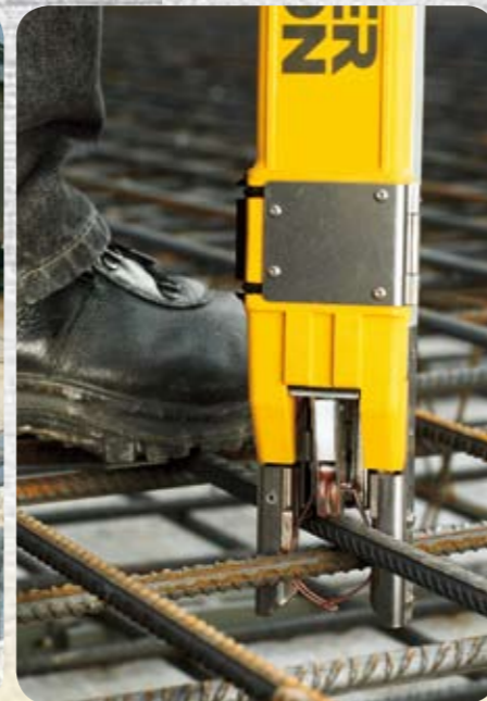
Fase 4: Il rinforzo viene montato e viene lavorato con legaferrì manuali per armature e con cesoie portatili per armature Wacker Neuson.
