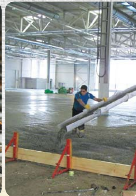
Fase 5: Il calcestruzzo fresco viene consegnato e posato.
