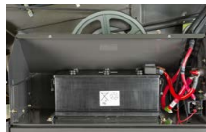
Une batterie 12 V alimente la gestion électronique moteur et le système électronique embarqué. Elle est logée dans un coffre à batterie bien accessible.
